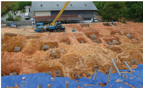
“梁琬清教学楼”施工中。
